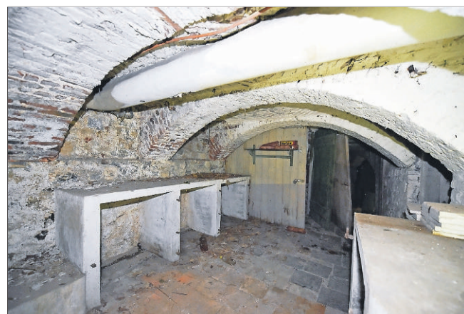
Blick in das Kellergewölbe.
